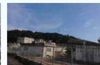
甲山浄水場現状
