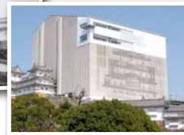
▼ 平成の大修理
