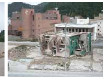
▲ 横倒しになった女川町のビル
